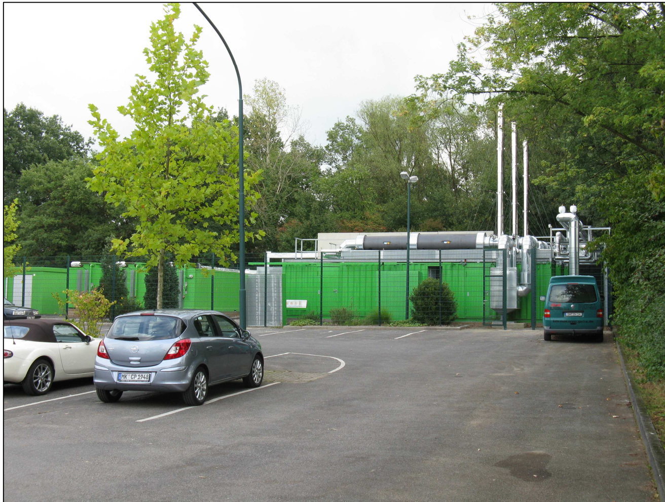
vor Montage der Schallschutzeinhausung
